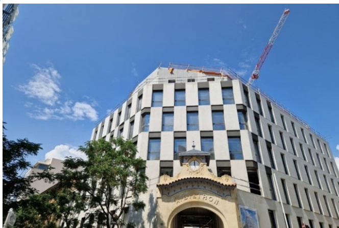
Figure 19 : M Factory |Marseille (13) |BBC-Effinergie 2017 | MO : Icadet |Architecte : Rougerie + Tangram | Crédit photo : Tourisme Marseille
