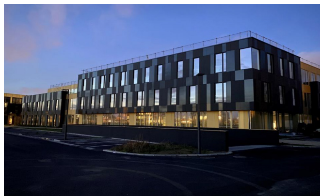
Figure 27 : L'Arteparc Bat L/M| Bepos Effinergie 2013 | Lesqui (59) | Architecte : Agence VBI| MO : Arteprom
