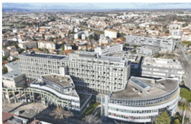
Figure 9 : Rénovation « La Barre » |Valence (26) |Basse Consommation | MO : Préfecture et Conseil Départemental de la Drome|Crédit Photo : @Francis Rey
