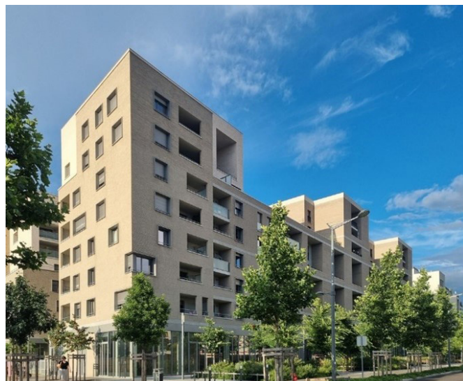
Figure 24 : Lot 11 Zac des Girondins | Bepos Effinergie 2013 | Lyon (69) | MO : SCI Lyon Rue des Girondins.
