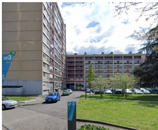
Figure 3 : Résidence UC3| Bron (69) | BBC Effinergie Rénovation (2024)
