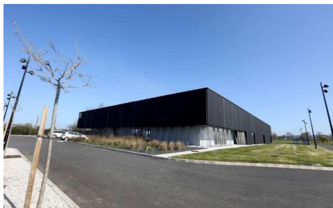
Figure 26 : Extension de l'atelier de Tissage|Bepos Effinergie 2013 |Uzeins (64) | MO : ACT3| Architectes : LC2S Architectes
