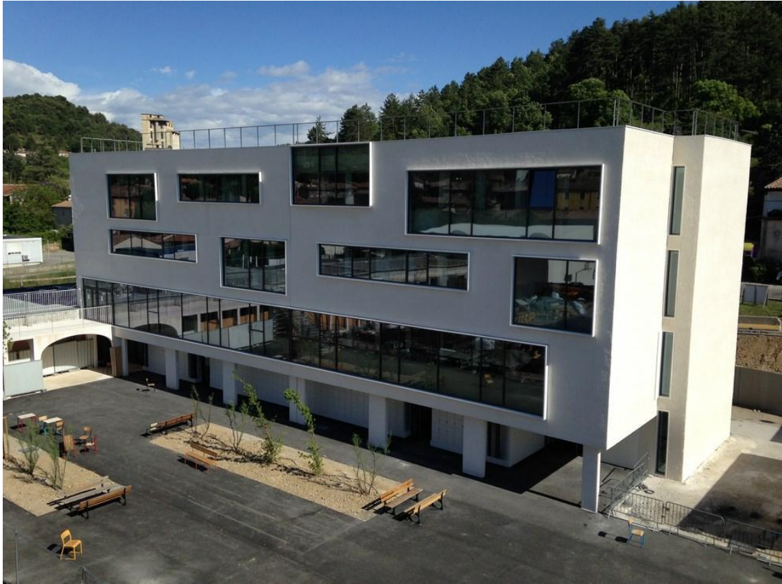
Figure 22 : Rénovation basse consommation – Collège Maxime Javelly – MO : Conseil Départemental des Alpes de Haute Provence
