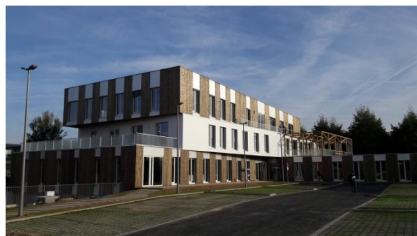
Figure 7 : Bureaux WAP– Bepos Effinergie 2013 – MO : Projectim – Architecte : De Alzua+
