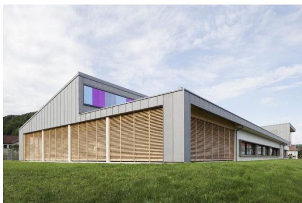
Figure 9 : Groupe Scolaire de la commune de Sancey – Appel à projet Bepos Effinergie 2013 – Architecte : Archi.tech – Région Bourgogne Franche Comté
