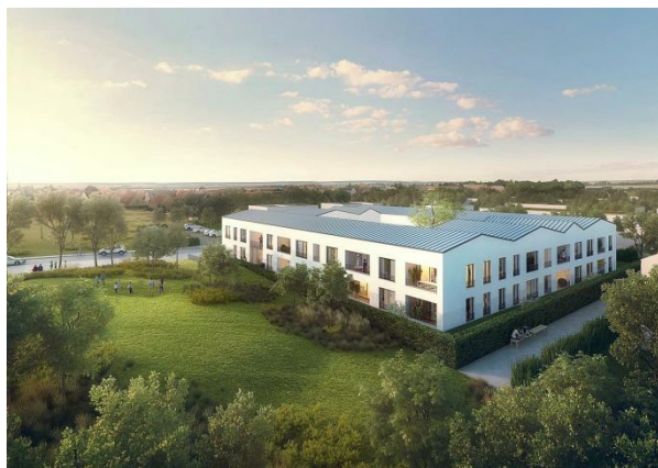
Figure 5 : Résidence Zac de la Maslière – Bepos Effinergie 2013 – MO : Immobilière Basse Seine – Architecte : BE Paris – Baumschlager Eberle
