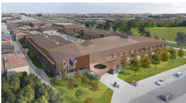
Figure 4 : Collège J.Ellul – Bepos Effinergie 2017 – MO : Département de la Gironde – Architecte : Latour Salier
