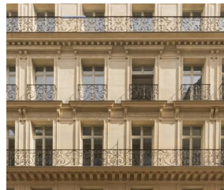
Figure 1: Rénovation Rue Drouot-Chauchat – DTACC - @Thierry Lewenberg-Sturm
